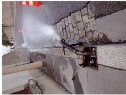
Bouche de lavage utilisée avec un « col de cygne »
