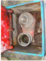
Bouche Incendie de 80 mm à raccord Keyser
