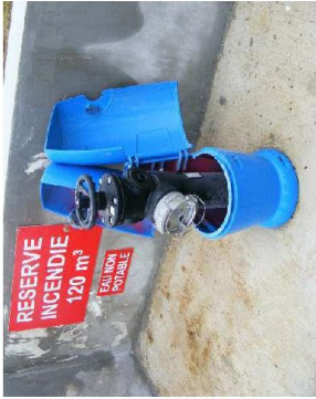
Poteau d'aspiration de 100 mm, muni d'une seule sortie de 100 mm et d'un volant de manoeuvre
