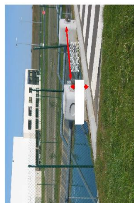
Plate forme d'aspiration sur une réserve d'eau équipée de deux colonnes d'aspiration de 100 mm
