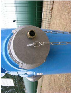
Poteau d'aspiration de 150 mm muni d'un Airclap
