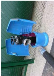
Poteau d'aspiration de 100 mm
