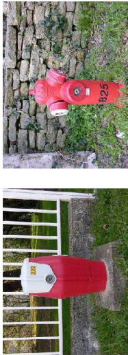
Exemples de numérotation de poteaux incendie
