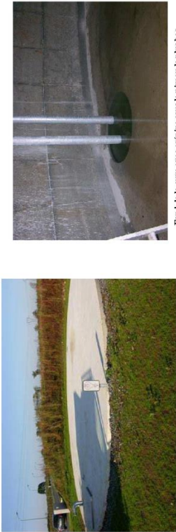
Fond de la cuve avec crépine sous le niveau le plus bas de l'eau
