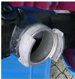
Poteau d'aspiration de 100 mm, muni d'une sortie de 100 mm, avec raccord fixe
